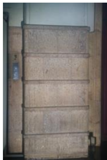
1 階ロビーの柱の日華石
