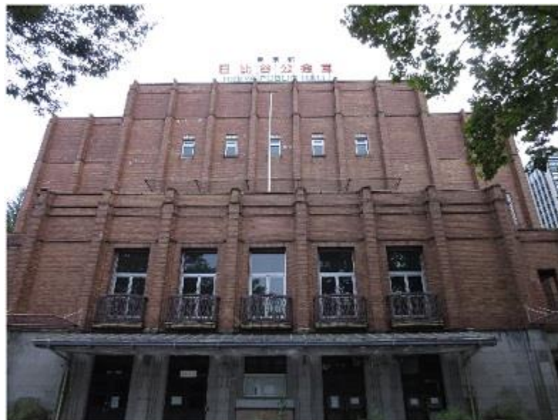
名古屋市公会堂と共通する、公園のに佇むスクラッチタイル貼りの落ち着いた外観
